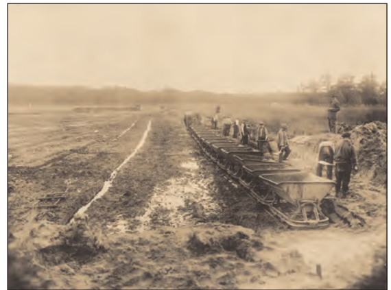
>> St. Hubertus, werkzaamheden aan de vijver
